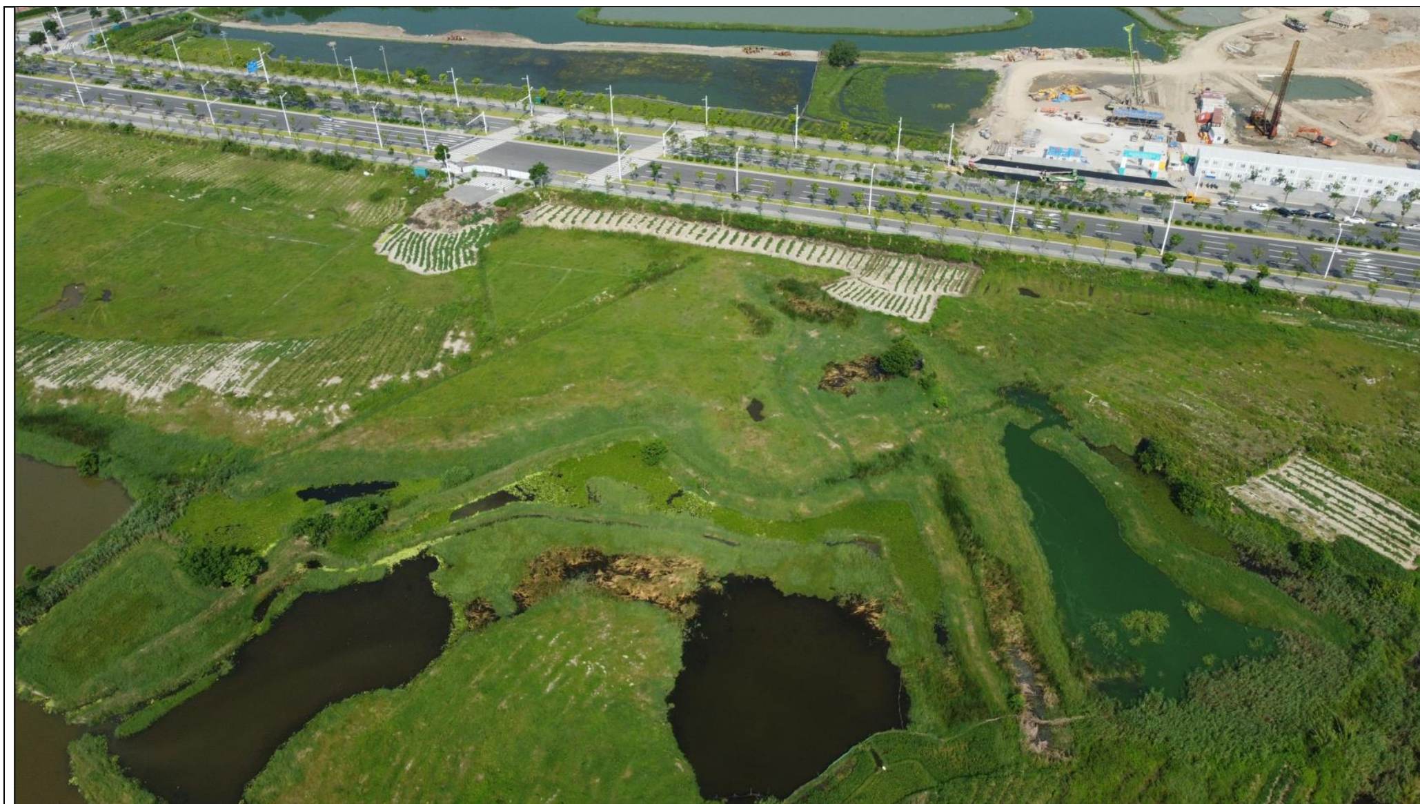
医院拟建场地东侧纪胜路及空地
